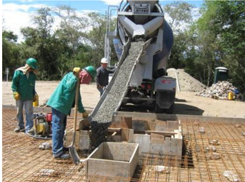
Imagen 1. Construcción de placa en concreto en una locación petrolera.
