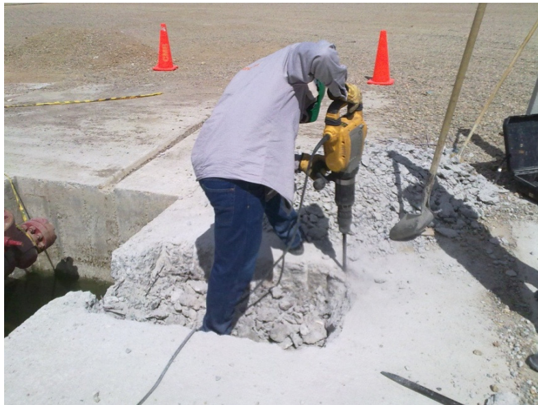
Imagen 6. Actividades de demolición.
