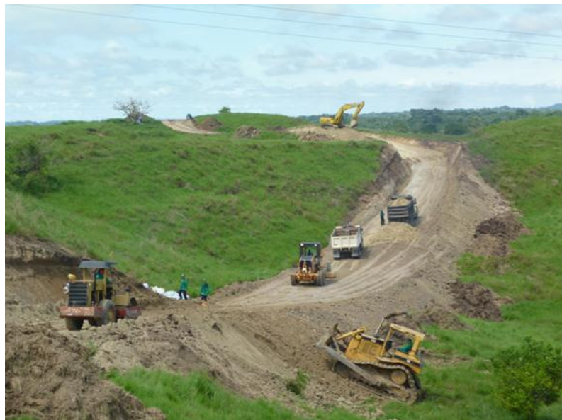
Imagen 2. Construcción y mantenimiento de vías para el sector petrolero.
