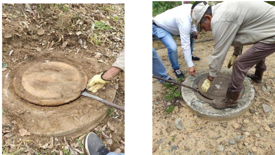
Figura 3-4: Levantamiento de las tapas de alcantarillado
