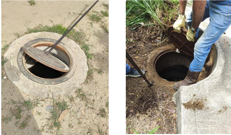
Figura 3-5: Ventilación de pozos
