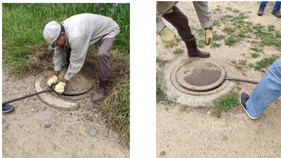
Figura 3-3: Inspección de los pozos existentes de la vereda la Mata
