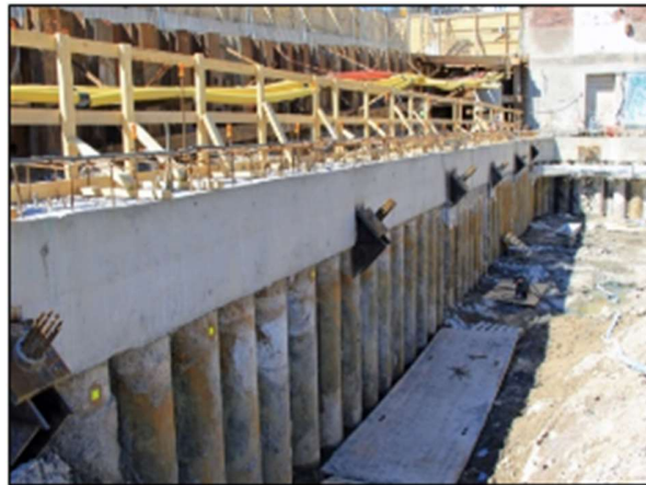
Figura 1-1: Sistema de retención por pilotes anclados, para la construcción del edificio K6, Helsinki-Finlandia (Infrastructure news, 2017).
