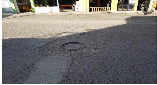
Exposición de las juntas transversales, descascamiento con severidad alta en pavimento rígido, exposición de agregado pétreo.
