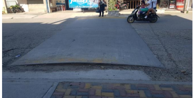
Surcos, pérdida de agregados, desportillamiento en fisuras y junta, fisuración incipiente.
