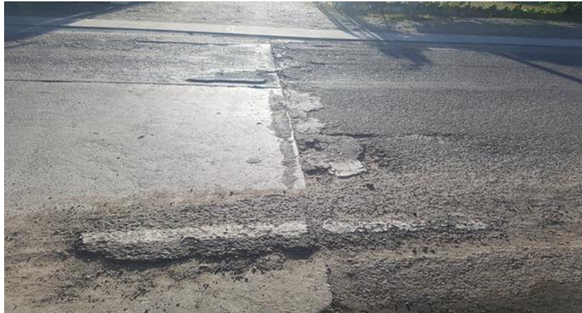
Surcos, pérdida de agregados, desportillamiento en fisuras y junta, fisuración incipiente.
