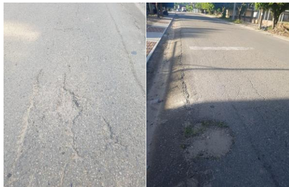
Fisuras longitudinales, bache y desportillamiento de la carpeta asfáltica.
