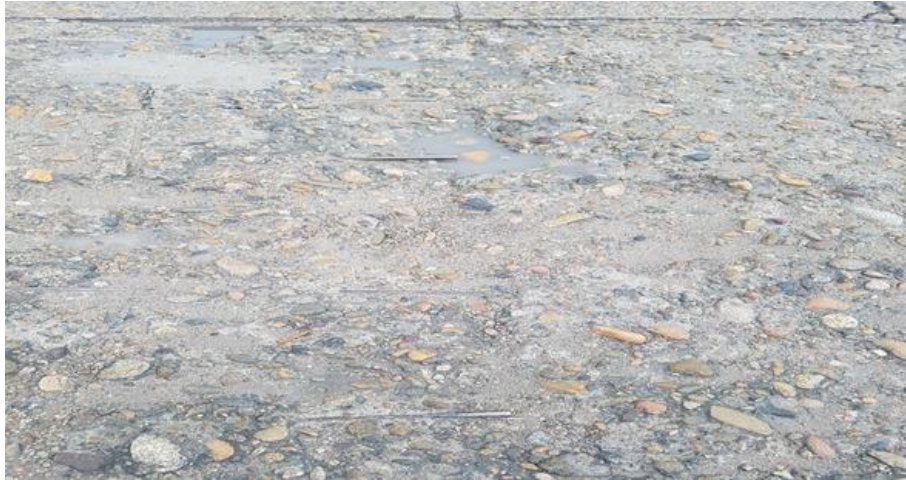
Exposición de las juntas transversales, descascamiento con severidad alta en pavimento rígido, exposición de agregado pétreo.
