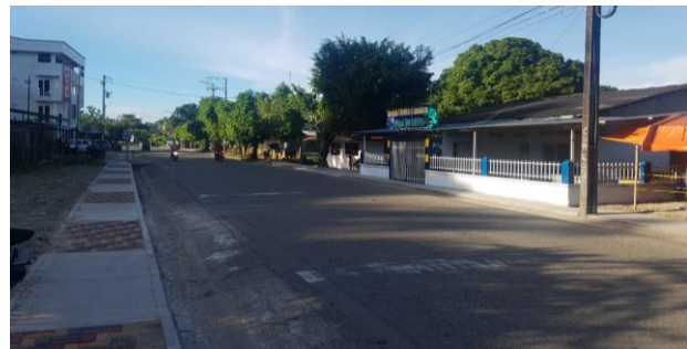
Desgaste demarcación vial. Agrietamiento capa de rodadura.
