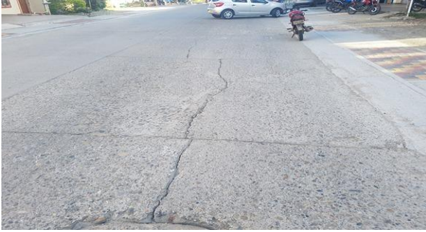
Surcos, pérdida de agregados, desportillamiento en fisuras y junta, fisuración incipiente.
