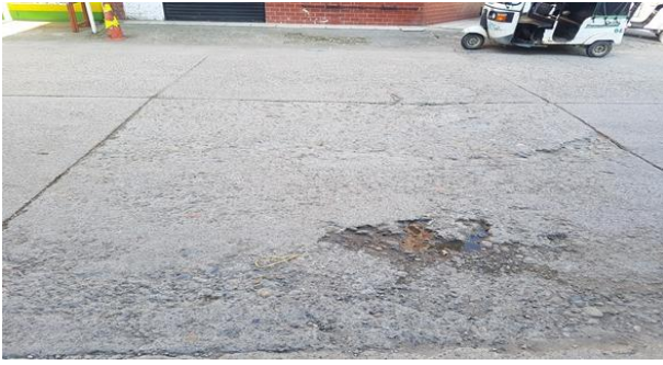
Desgaste demarcación vial. Reductor de velocidad sin señalización SP-25 "Resalto". Peatones en vía.
