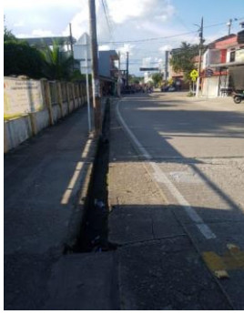
Exposición de las juntas transversales, descascamiento con severidad alta en pavimento rígido, exposición de agregado pétreo.
