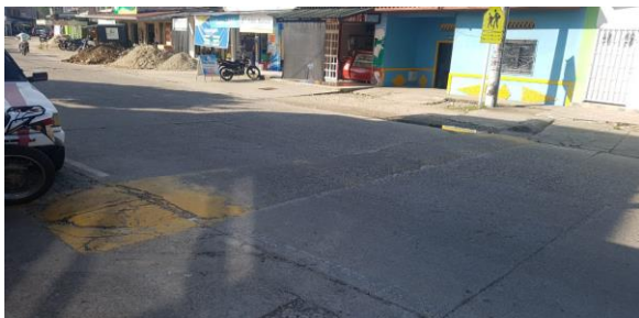
Reductor de velocidad sin señalización y deterioro en la demarcación.
