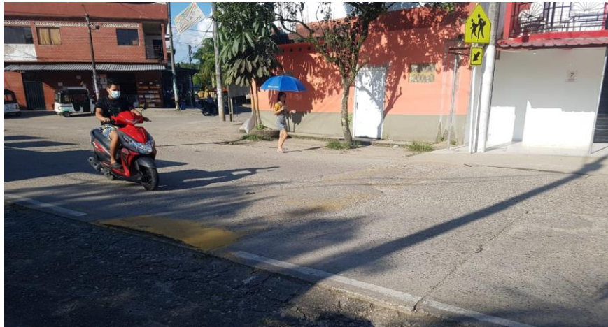
Desgaste demarcación vial. Reductor de velocidad sin señalización SP-25 "Resalto". Peatones en vía.
