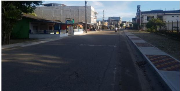
Fisuras longitudinales, bache y desportillamiento de la carpeta asfáltica.
