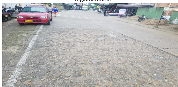
Deterioro en: demarcación vial, pavimento rígido. No existe acera peatonal reglamentaria.
