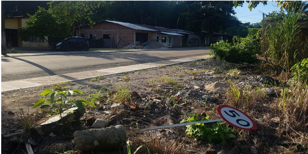
Fotografía 4-6: Señalización vertical y horizontal de la vía. Tomada por los investigadores subtramo K0+00 hasta K0+100.
