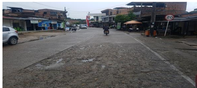
Deterioro en: demarcación vial, pavimento rígido. No existe acera peatonal reglamentaria.
