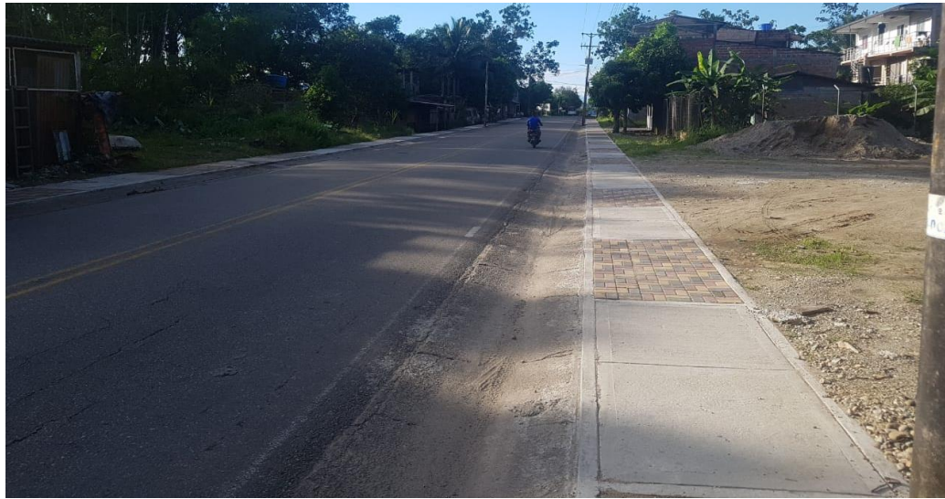
Fotografía 4-5: Vía nacional de Puerto Caicedo, Putumayo. Tomada por los investigadores, subtramo K0+00 hasta K0+100.
