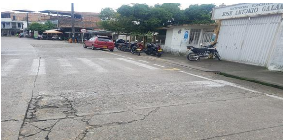
Reductor de velocidad sin señalización y deterioro en la demarcación.
