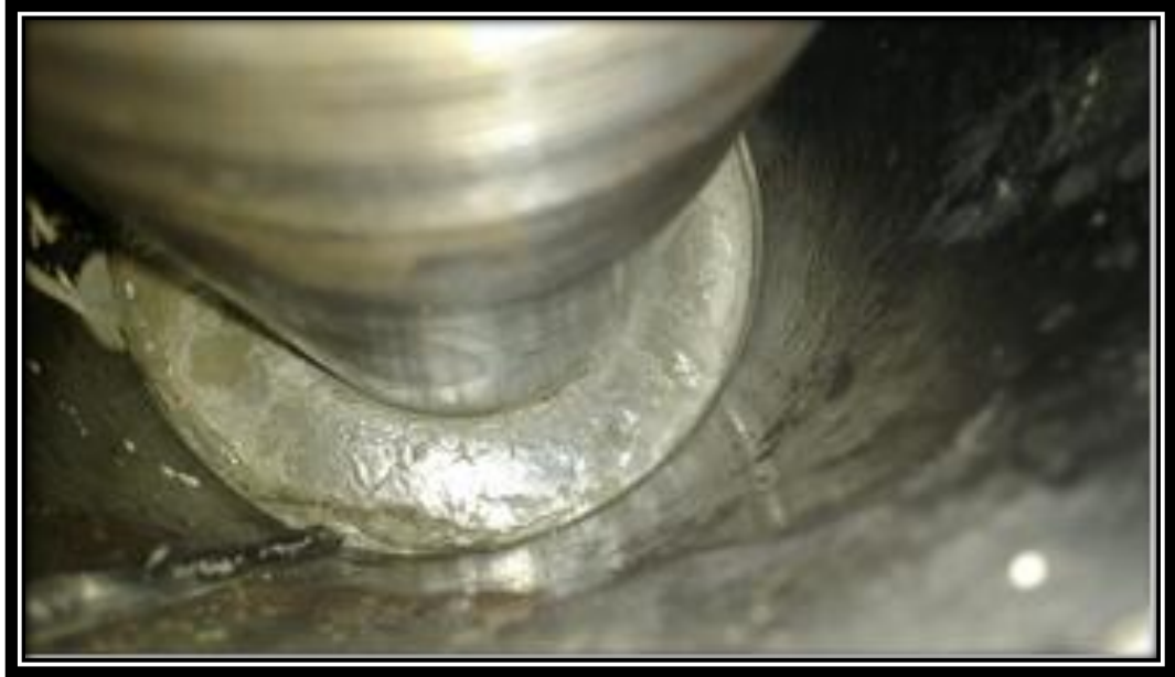
Figura 16. Lechada con aditivo controlador de migración de gas Fuente: Autores
