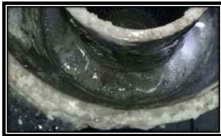
Figura 10. Gas migrando a través del cemento Fuente: Henríquez y Serrano, 2016 [9]
