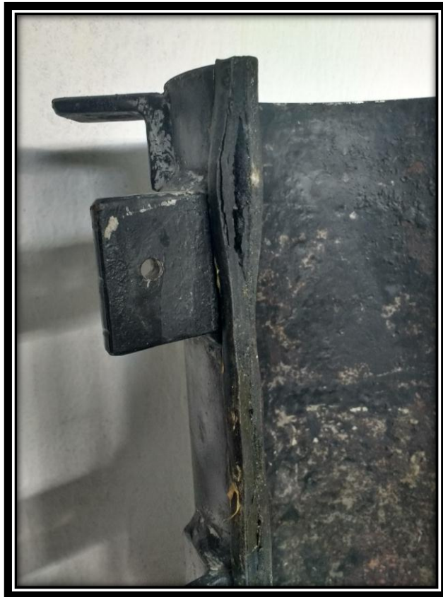
Figura 6. Daño en empaque lateral Fuente: Autores
