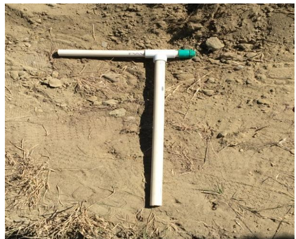
Ilustración 14: Sistema de drenaje para lixiviados.
