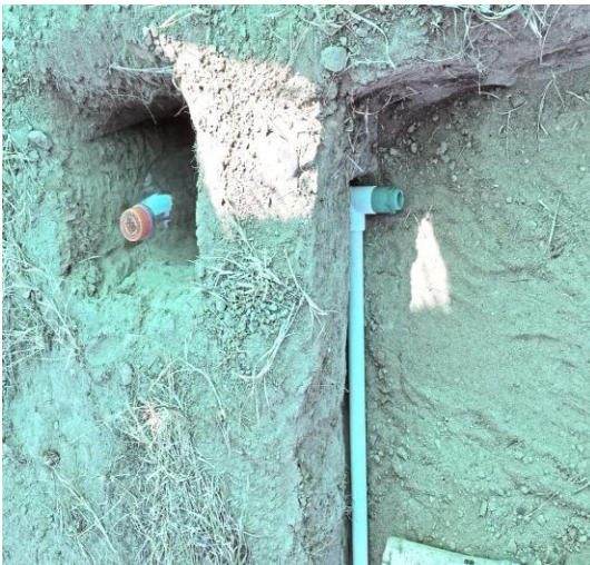
Ilustración 14: Sistema de drenaje para lixiviados.
