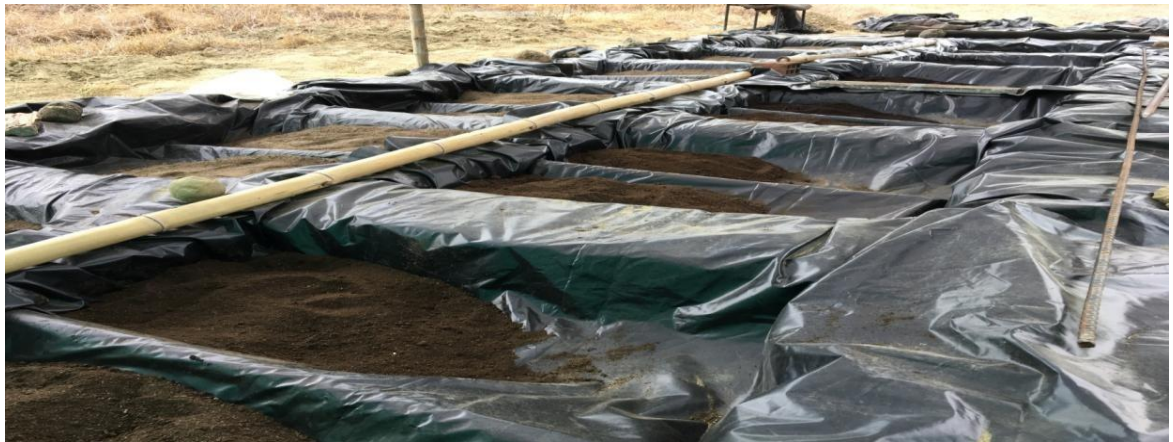
Ilustración 14: Sistema de drenaje para lixiviados.
