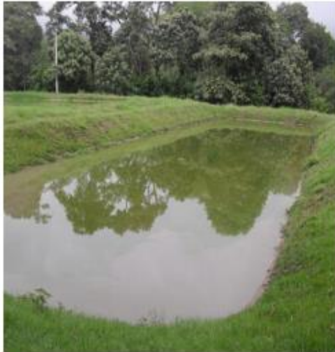
Laguna tratamiento PTAR
