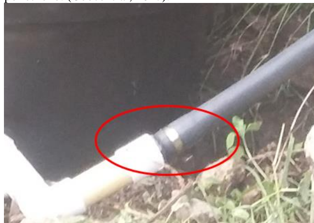
Figura 27.) Empalme tubería PVC a manguera de polietileno. (Coocentral, 2017).
