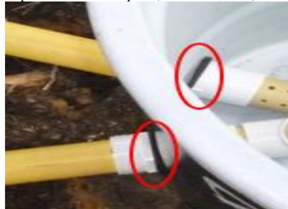
Figura 25.) Elementos que se utilizan al introducir dispositivos en los tanques. (Coocentral, 2017).
