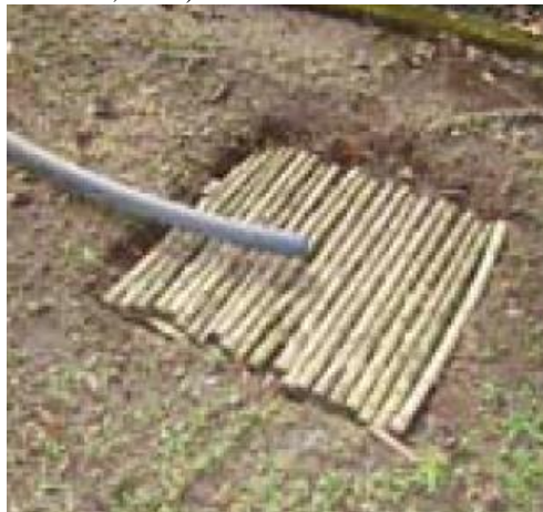
Figura 16.) Excavación para reboses. (FNC-Cenicafé, 2010).
