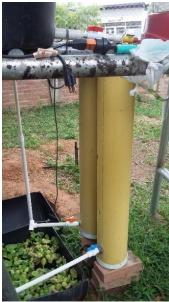
Figura 7. Filtros descendientes de arena
