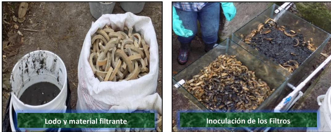
**Figura 20.** Inoculación al arranque del sistema
