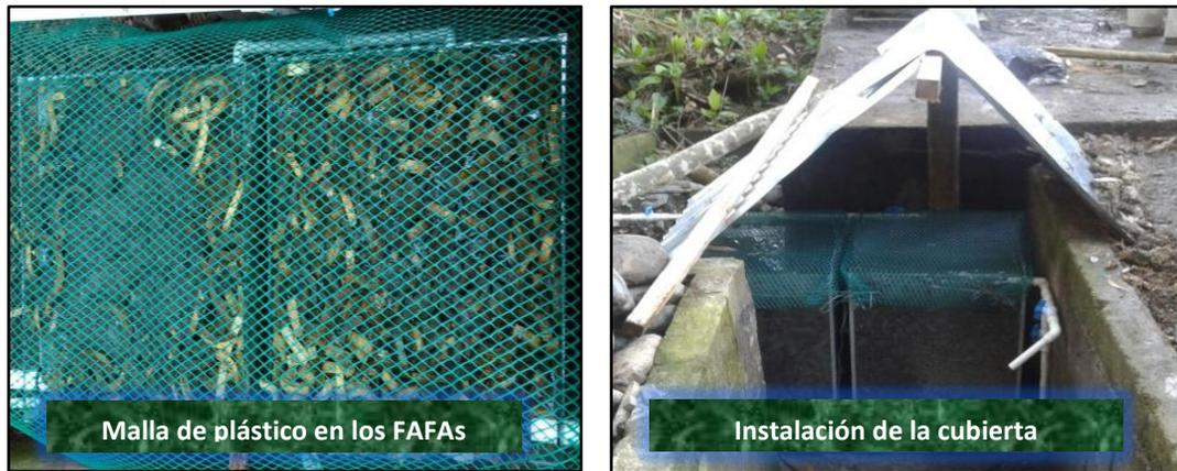
**Figura 17.** Material filtrante y accesorios de la zona de empaque
