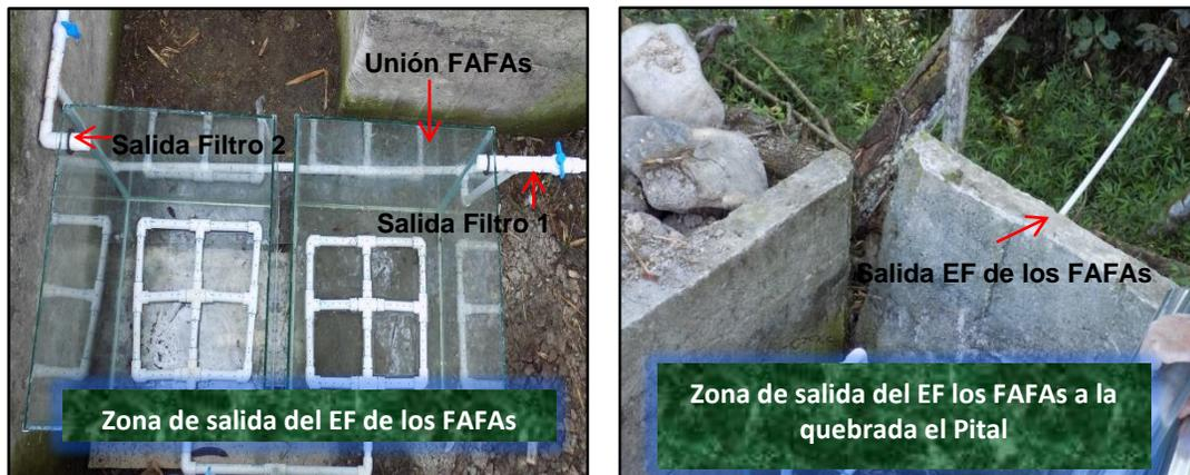
**Figura 18.** Zona de salida del EF de los FAFAs
