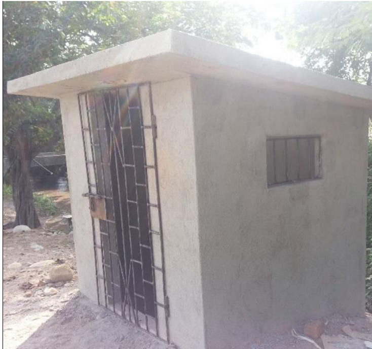
Imagen 7. Caseta de bombeo
