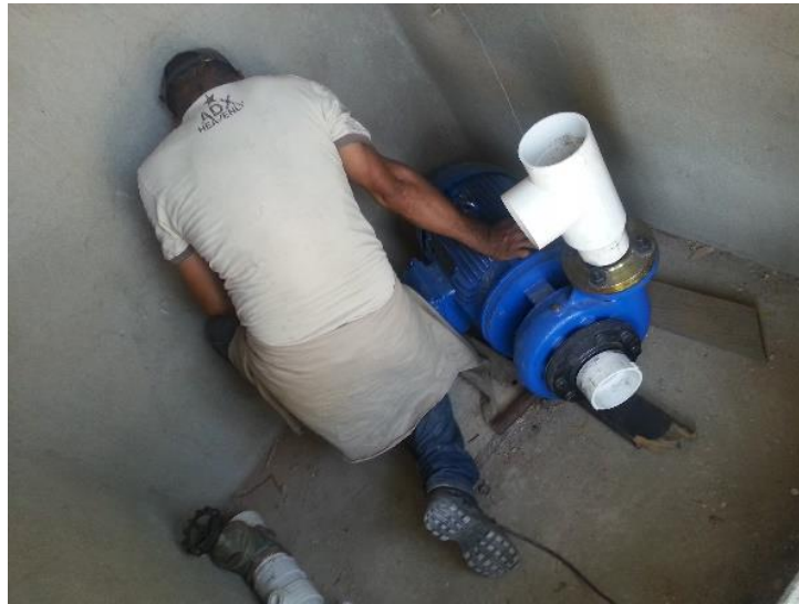
Imagen 8. Instalacion del sistema de bombeo
