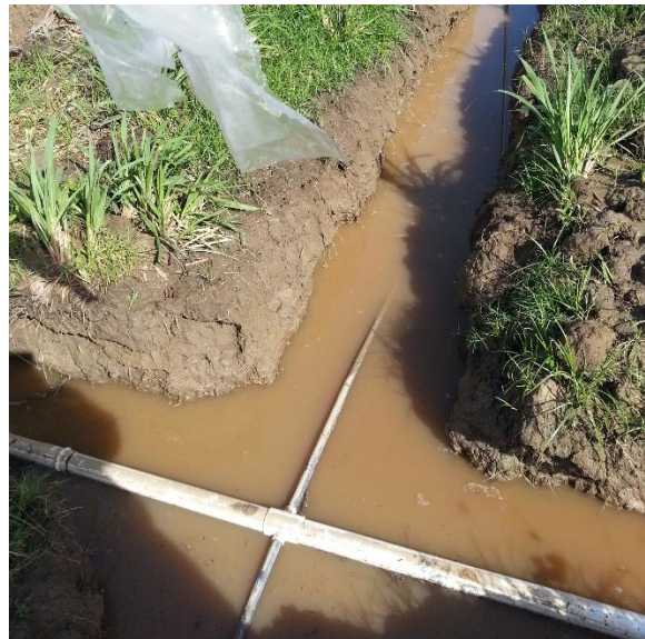
Imagen 11. Instalacion del múltiple y el lateral
