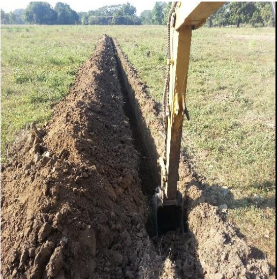
Imagen 9. Instalacion de la tubería principal
