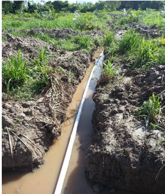
Imagen 10. Instalacion de la tubería de alimentación
