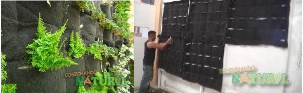
Figuras 10 y 11. Muros verdes por bolsillo de siembra [21].
