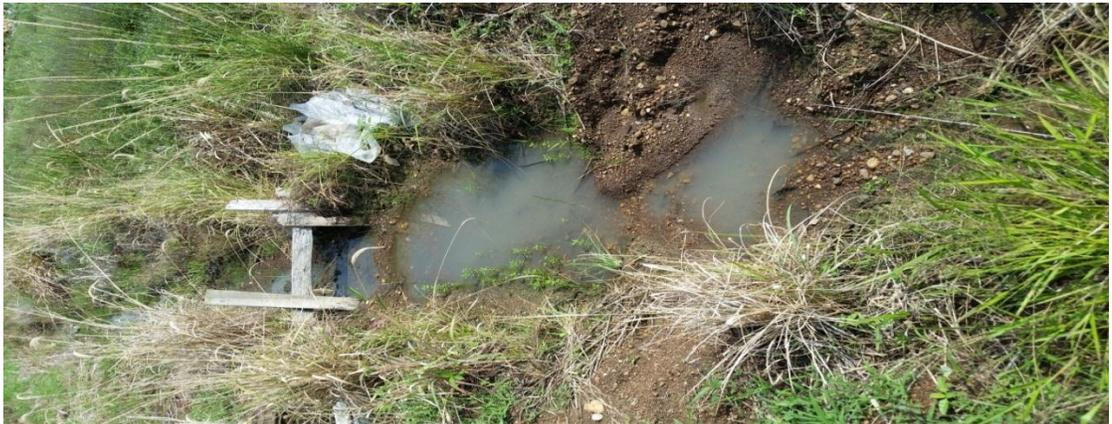
**Figura 33.** Compuertas improvisadas, canales en mal estado
