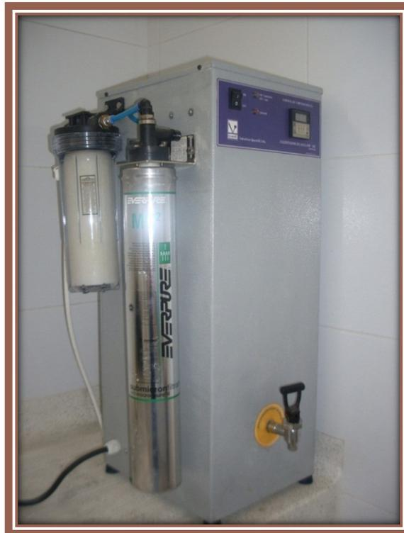
Figura. 13 Filtro y calentador de agua
