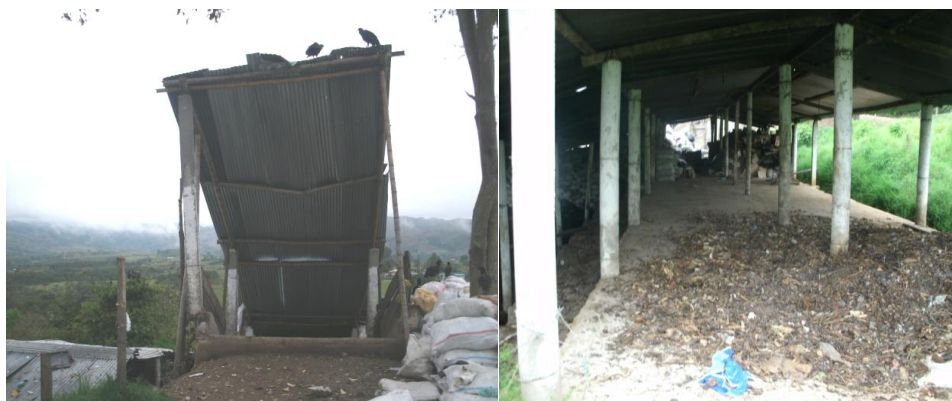
Figura 4. Rampa y cobertizo para almacenamiento del compost y material reciclado
