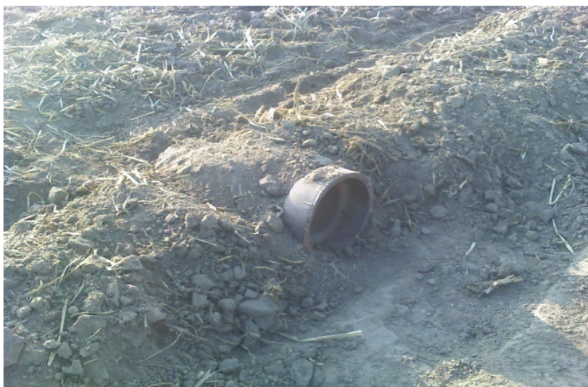
Foto 2. tubería aforada ya instalada
