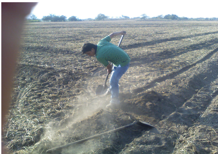
Foto 1. Preparación del terreno para instalar la tubería aforada
