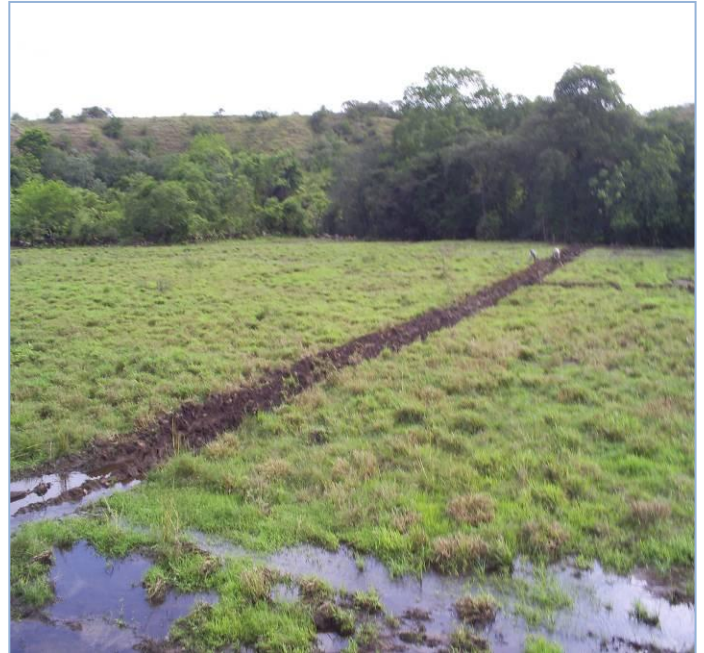
Fotografía 21 Panorámica de Excavación en Tuberías Múltiples.
