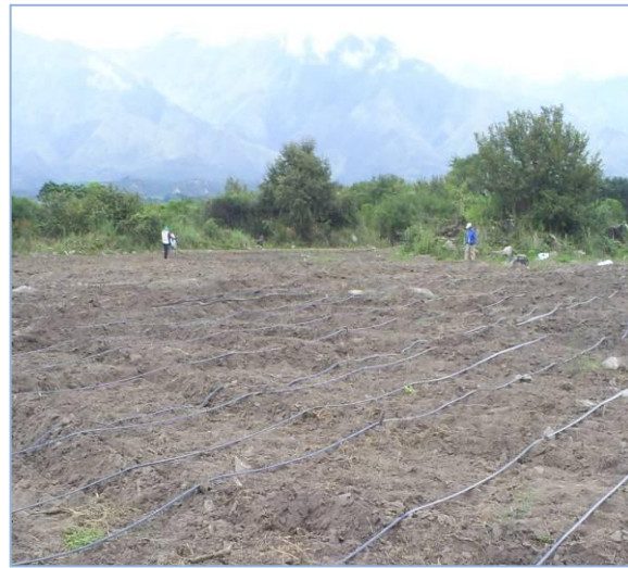
Fotografía 38 Proceso de Instalación de la Unidad de Riego.
