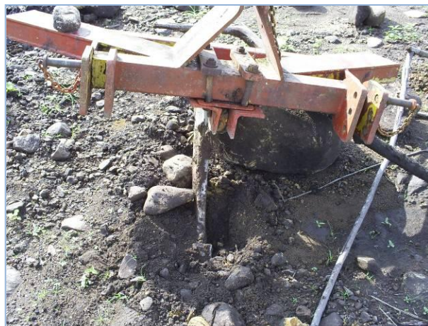
Fotografía 19 Implementos Utilizados Para Realizar las Excavaciones
