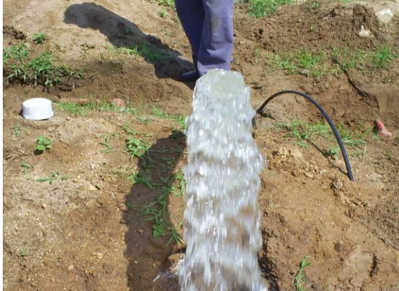
Fotografía 39 Lavado de la Tubería
