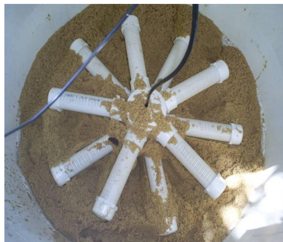
Fotografía 31 instalación de colectores en los filtro de arena
