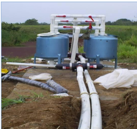
Fotografía 30 instalación unidad de filtrado
