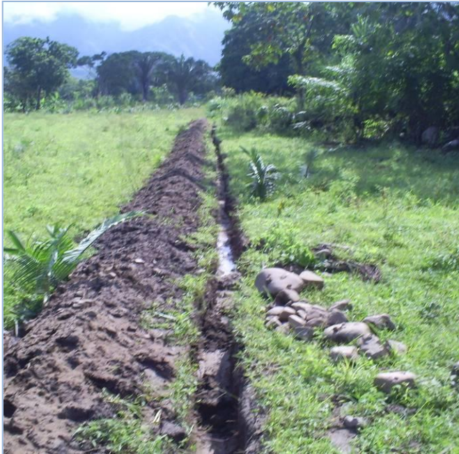
Fotografía 20 Excavaciones e Inconvenientes Por Rocas
