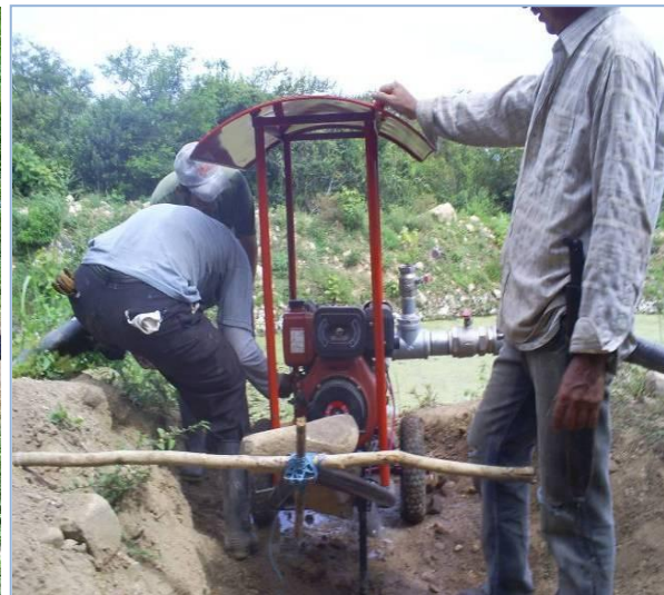
Fotografía 34 Puesta en Marcha Unidades de Bombeo
