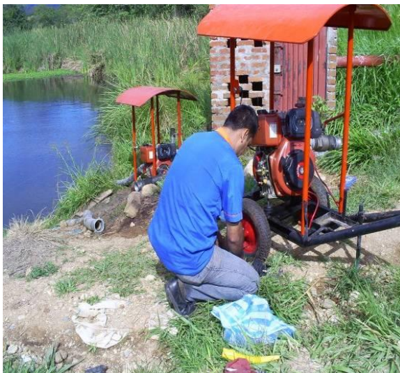
Fotografía 33 Instalación Unidades de Bombeo
