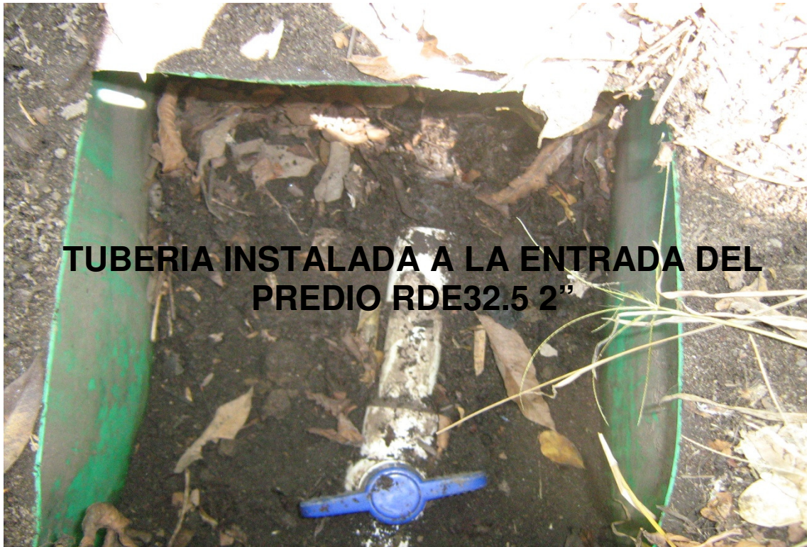
Fig. N.11. Toma predial instalada en el lote, derivada del distrito de riego El Espinal.
