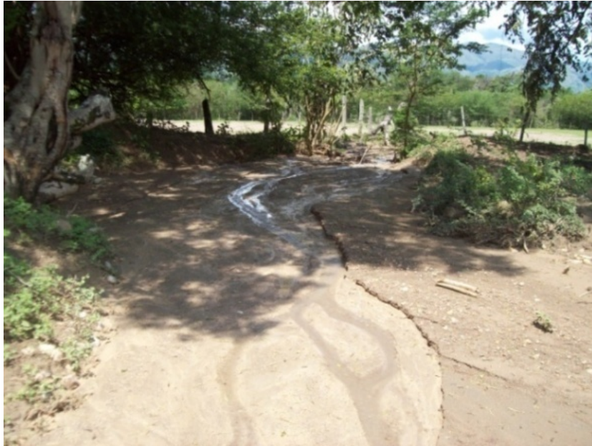
Foto 9. Sobresedimentación canal Doche
