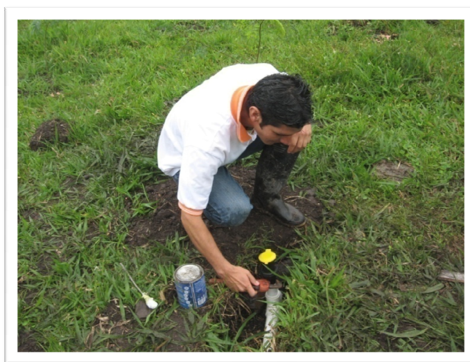
Figura 22. Instalación sistema de riego por aspersión, banco de proteínas
