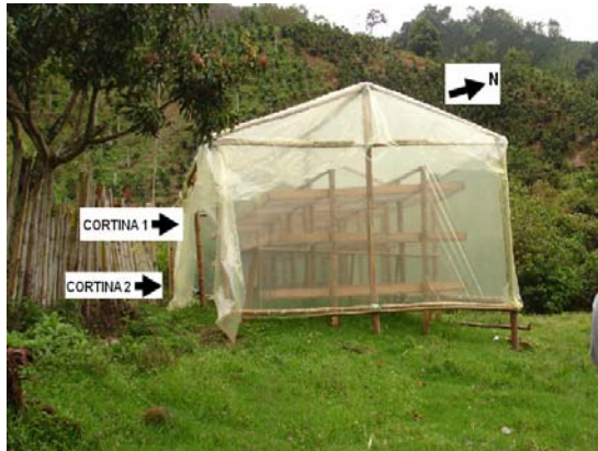
Figura 19. Vista lateral derecha del sistema y posición de las cortinas 1 y 2
