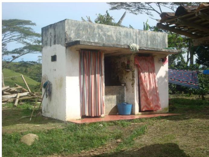
Foto 2. Baños de la vivienda en la finca La Cabaña.
