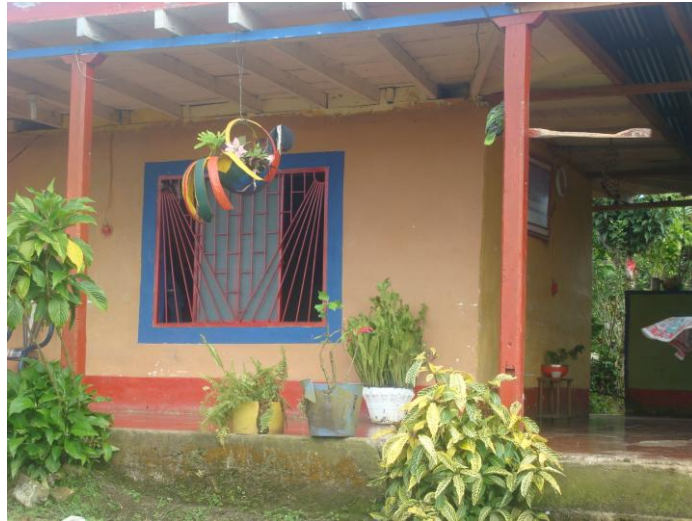
Foto 17. Estructura de la vivienda de la finca La Cabaña.
