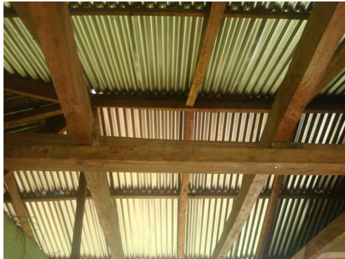
Foto 18. Cubierta de la vivienda de la finca La Cabaña.
