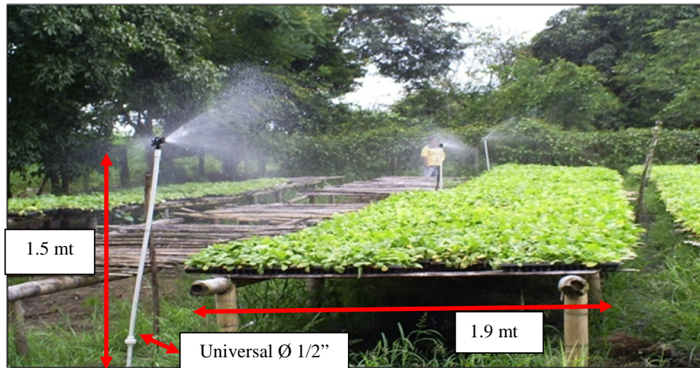
Figura 11. Instalación Disposición de tuberías y de unidades de riego en la parcela Villa de Leiva, vereda El Guadual.
