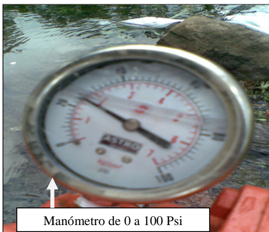
Figura 17. Verificación de la presión en el sistema, parcela El Recreo, Garzón.
