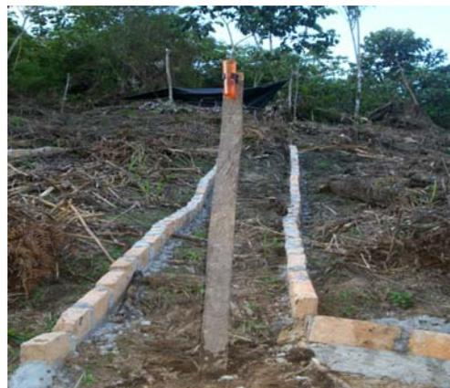
Foto 10. Instalación Pluviómetro
