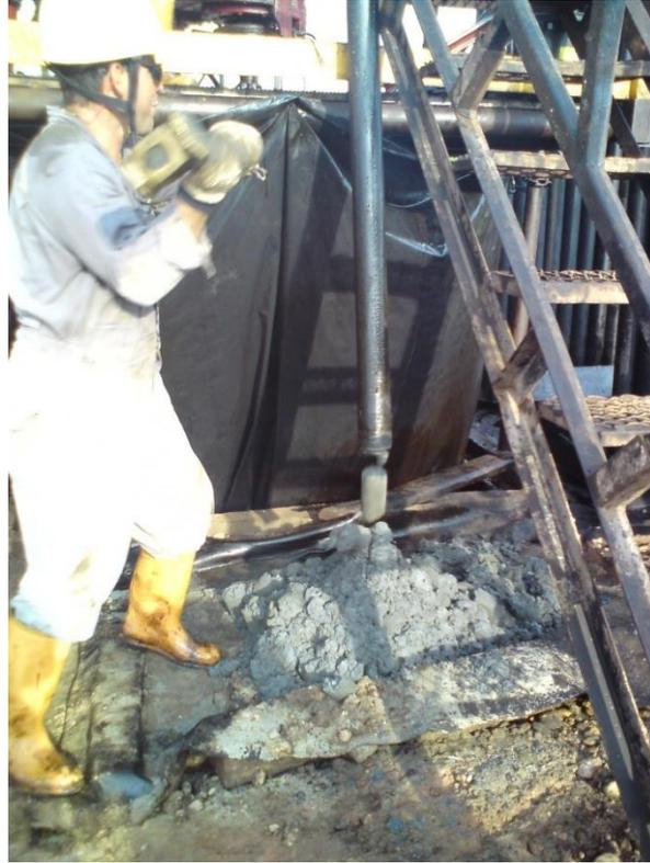
*Figura 10. Limpieza de arena, fuente: modelo analítico para la estimación del arenamiento de Pozos en LCI a Partir de Mediciones de Campo.*
