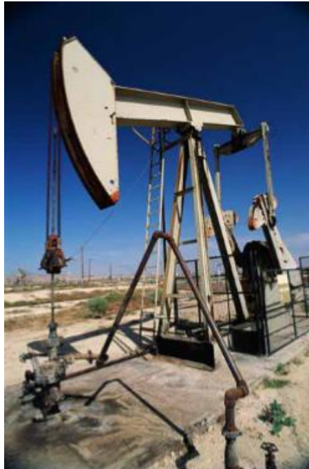
Figura 12. Unidad de bombeo mecánico convencional
