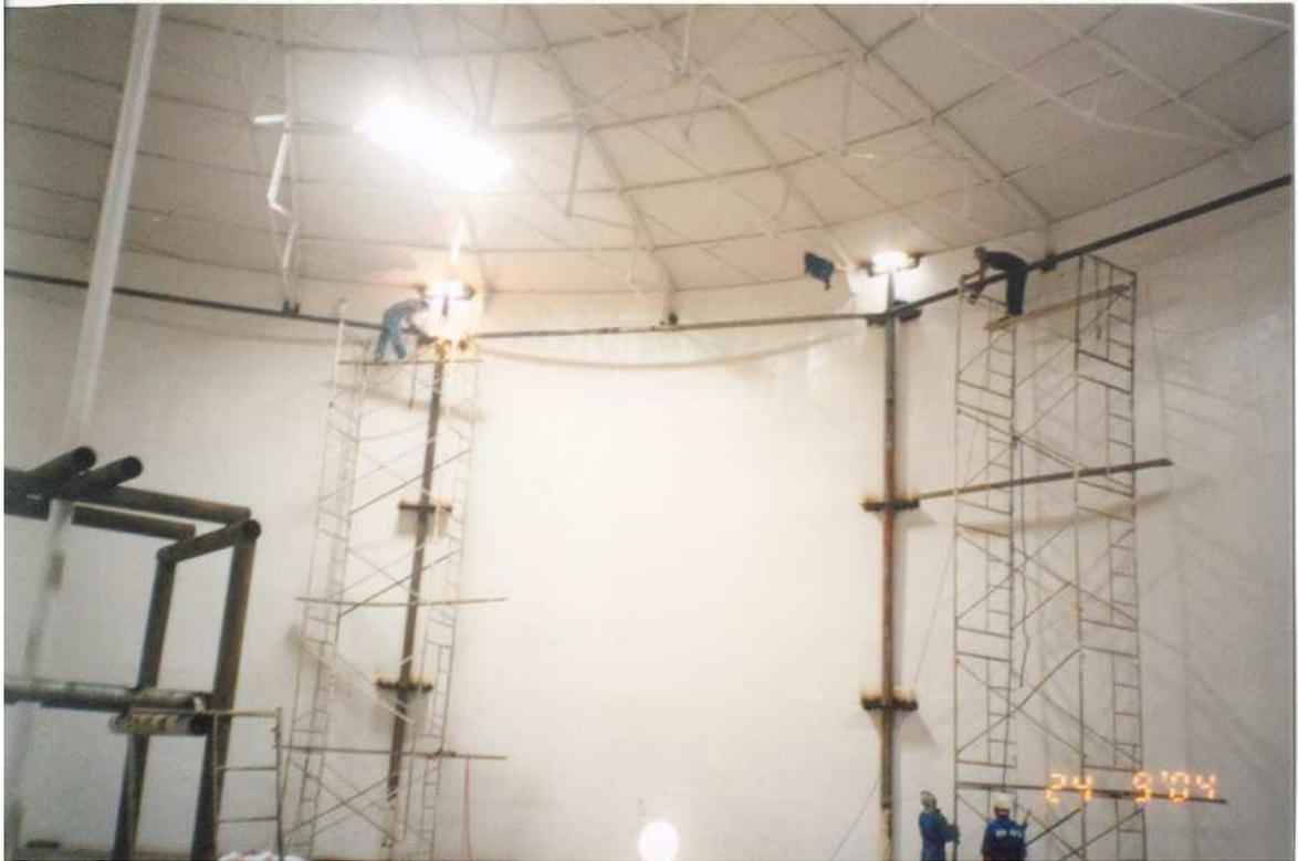
Figura A.3. Sujeción por Soldadura en Tanques de Almacenamiento.
