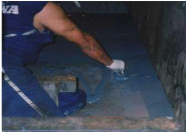
Figura A.32. Aplicación de pintura por medio de brocha.
