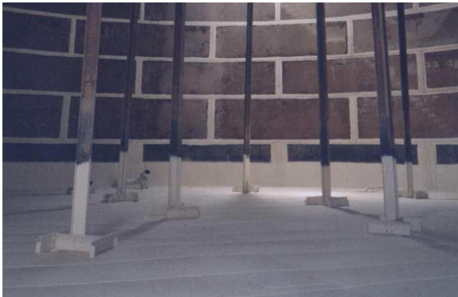
Figura A.6. Columnas Armadas montadas sobre la base del tanque.
