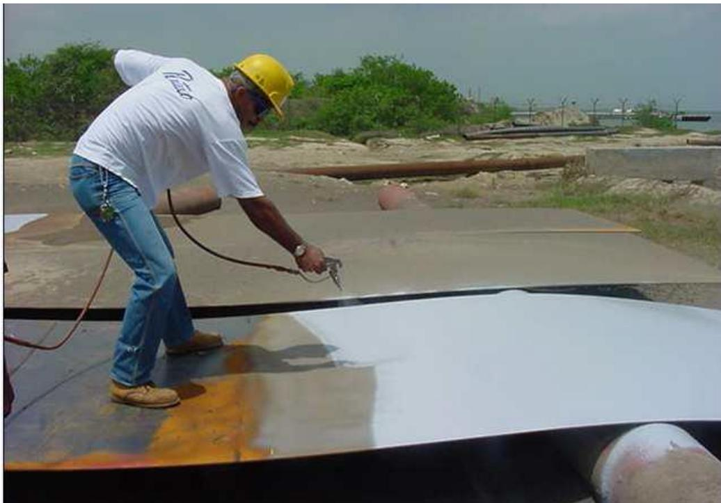
Figura A.33. Aplicación de pintura por medio de soplete.
