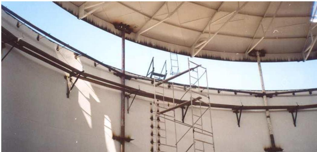
Figura A.11. Montaje de Cartelas- Unión Estructura-Envolvente Tanque.
