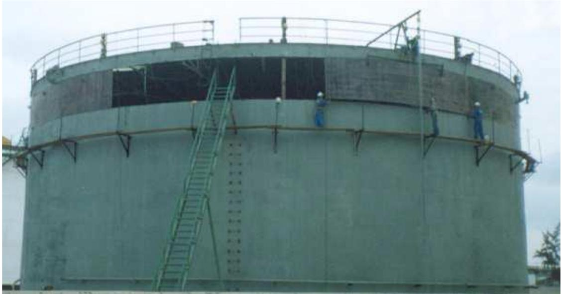
Figura A.10. Montaje de las Placas- Colocación y Ajuste.
