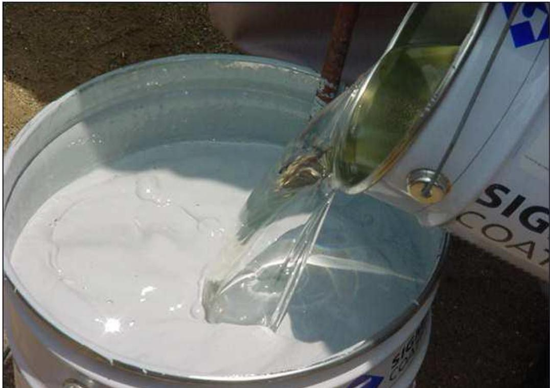
Figura A.31. Mezclado y Diluido de Pintura. Momento en que se agrega Thinner.
