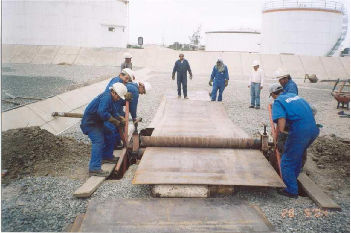
Figura A.2. Proceso de rolado de las láminas. Hombres rolado una lámina.
