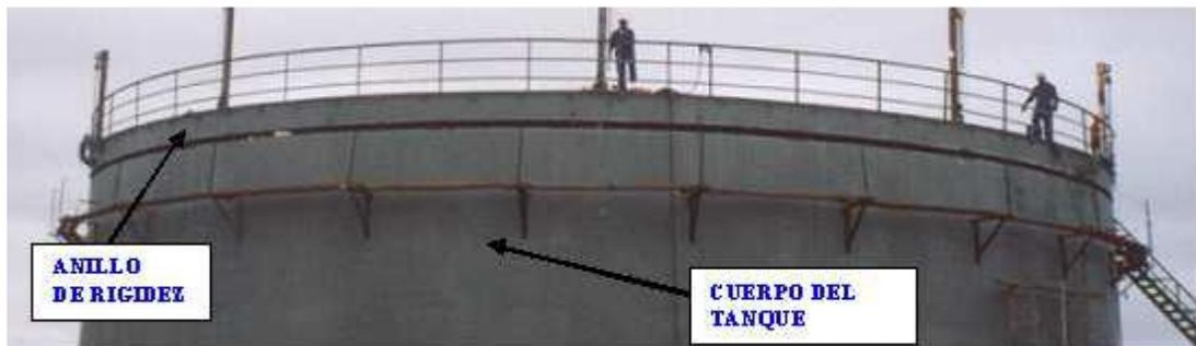
Figura A.12. Montaje del Anillo de Rigidez.
