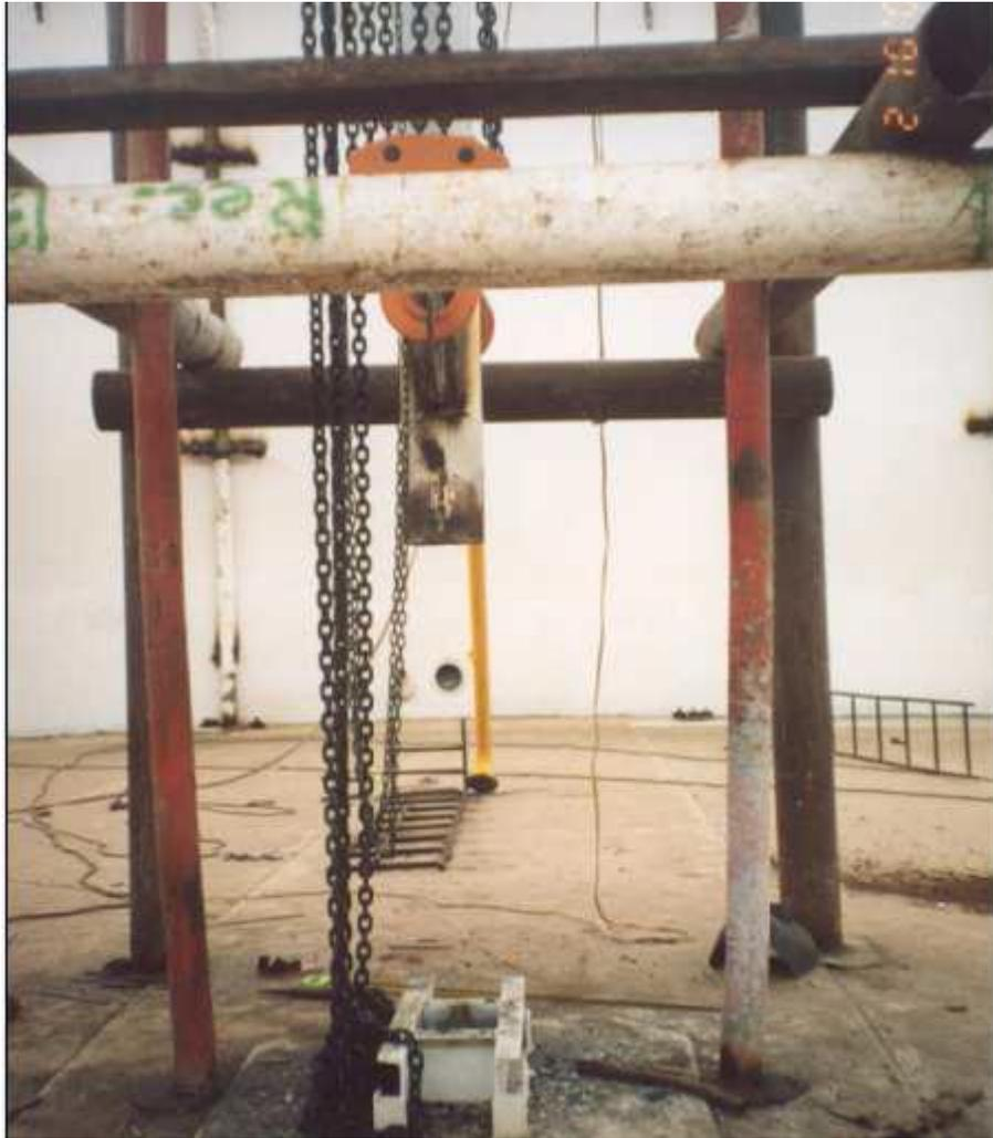
Figura A.7. Montaje de columnas-Estructura Auxiliar Soportante
