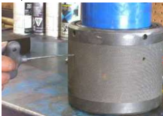
Figura 23 - Instalación de tornillos para asegurar el collar.
