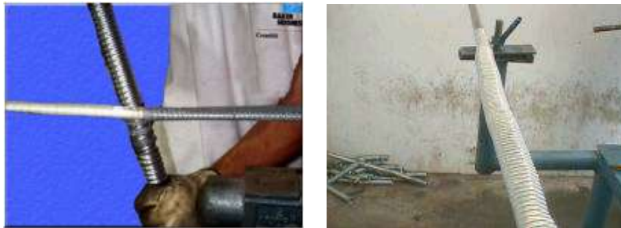
Figura 26. Colocación de la armadura al empalme de cable de potencia.
