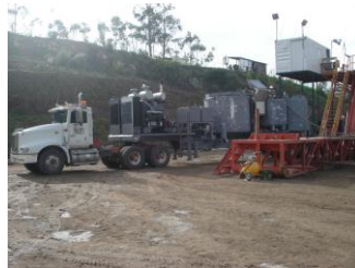
Imagen 21. Cementación del casing de 7 pulgadas
