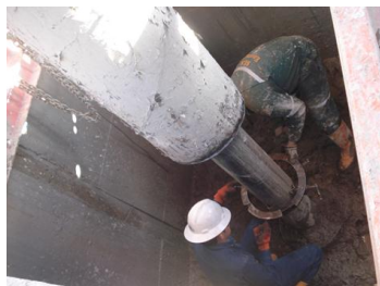
Imagen 13. Corte revestimiento de 9 5/8"
