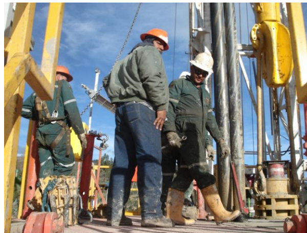
Imagen 11. Corrida de revestimiento
