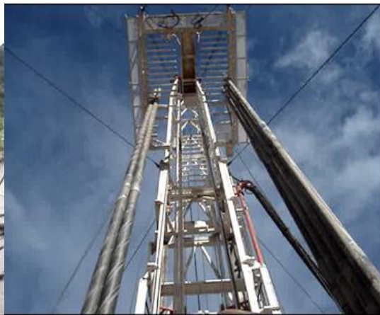
Imagen 5. Paradas de tubería sobre la mesa
