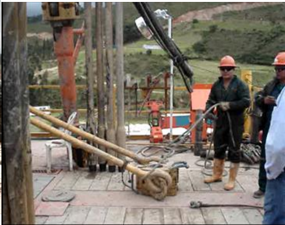
Imagen 9. Elevador de tubería
