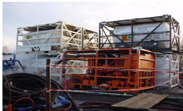
Figura 8: Unidad de Vaporización/Inyección de nitrógeno criogénico en uso para una operación de bajo balance
