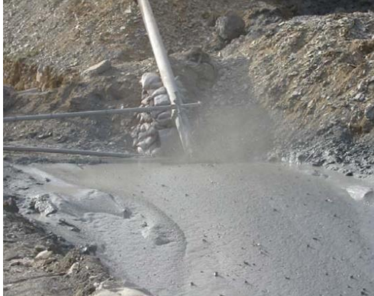
Figura 7: Vista del retorno de un sistema de espuma
