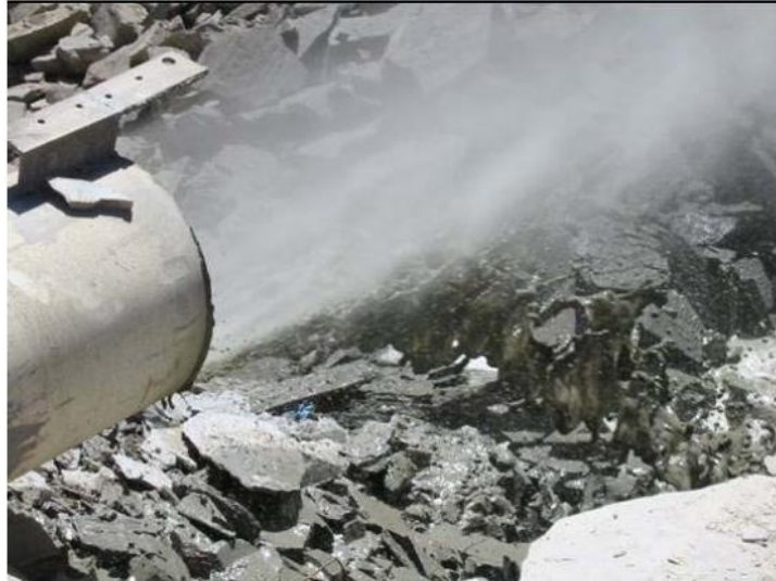
Figura 6: Retorno en superficie de un sistema de Niebla a través de la línea de retorno
