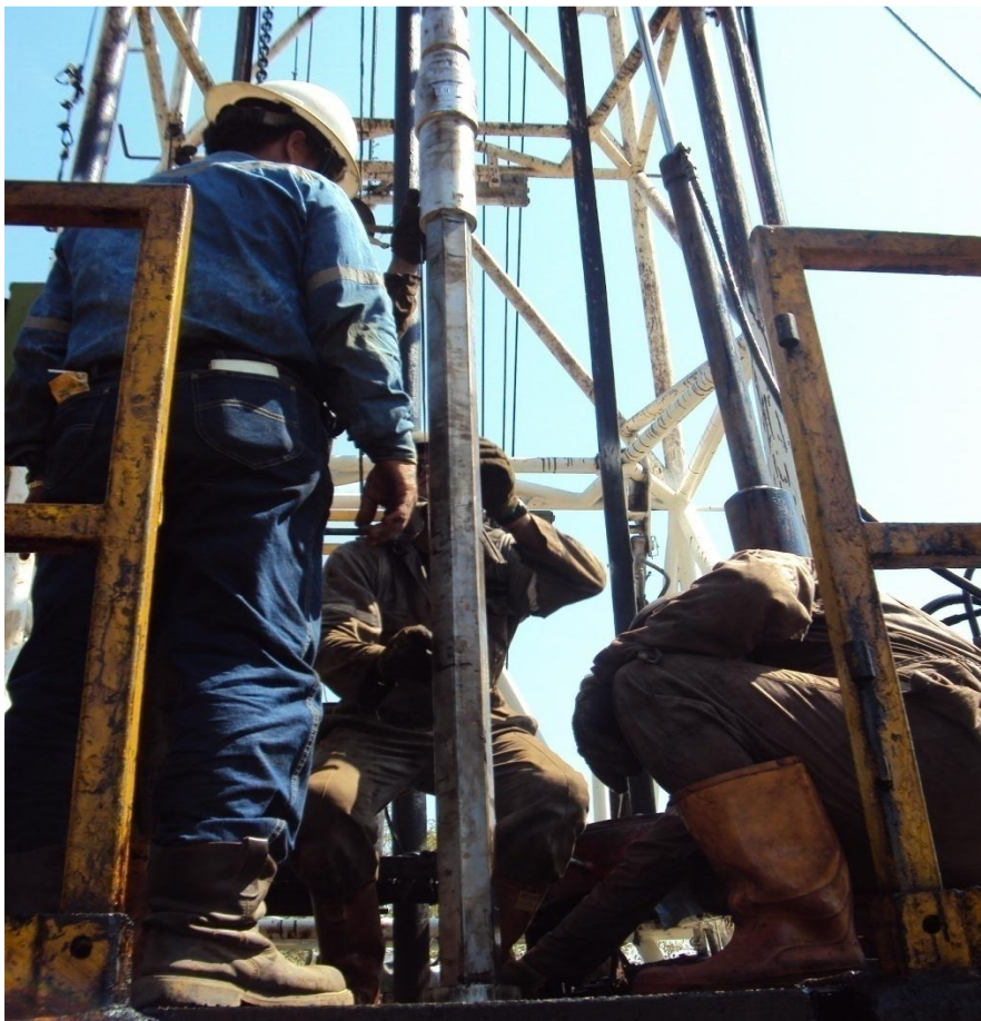
Figura 20. Bajada de Bomba Extractora de sólidos.
