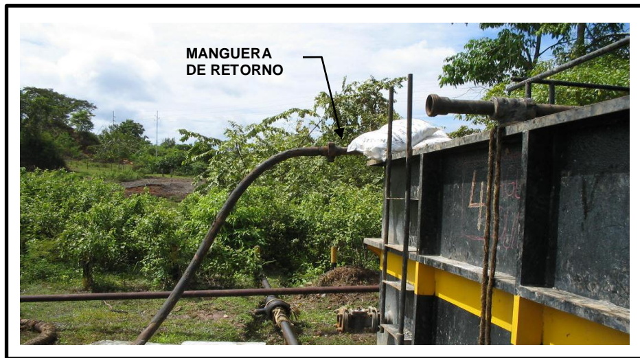
Figura 21. Instalación de líneas a tanque
