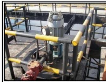
**FIGURA 22. Bomba Separador API**
