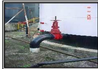
**FIGURA 5. Válvulas de entrada al Tanque Despacho    FIGURA 6. Válvula salida del Tanque Despacho**
