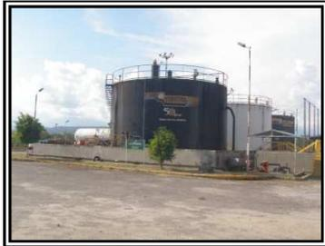
**FIGURA 14. Tanques Gun Barrel de 5000 Bls**
