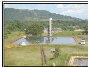
**FIGURA 21. Piscinas de Oxidación Uno y Dos respectivamente**
