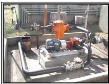
**FIGURA 25. Bomba Tanque de prueba**
