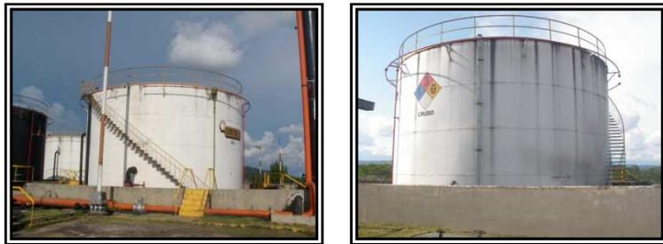
**FIGURA 17. Tanques de Almacenamiento de 5000 Bls**
