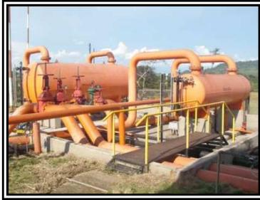
**FIGURA 18. Knock Out Drum de alta y de baja**
