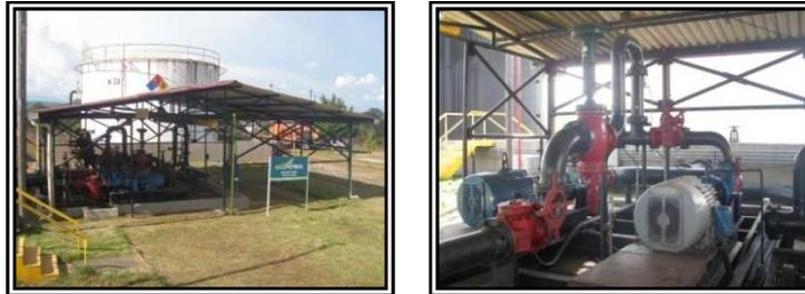
**FIGURA 27. Área de bombas y Bombas Ingersoll-Rand**
