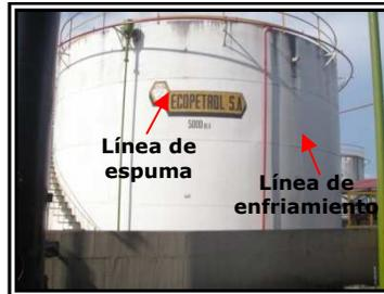
**FIGURA 37. Líneas de enfriamiento de tanques**
