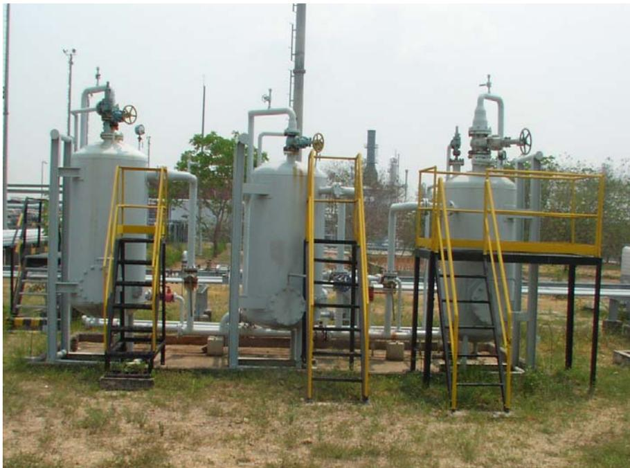
**Figura 1.8 Sistema de filtros A/B/C**
