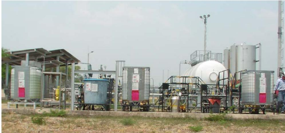
**Figura 4.2 Sistema de inyección de químicos**
