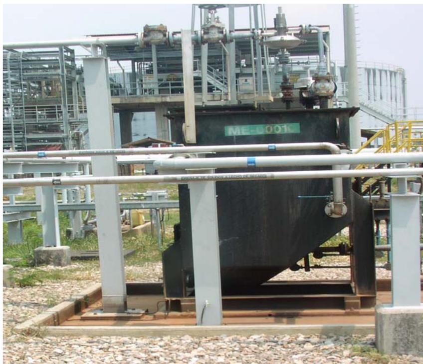
Figura 1.4 Separador de placas corrugadas “Separador de láminas acanaladas operado por gravedad”
