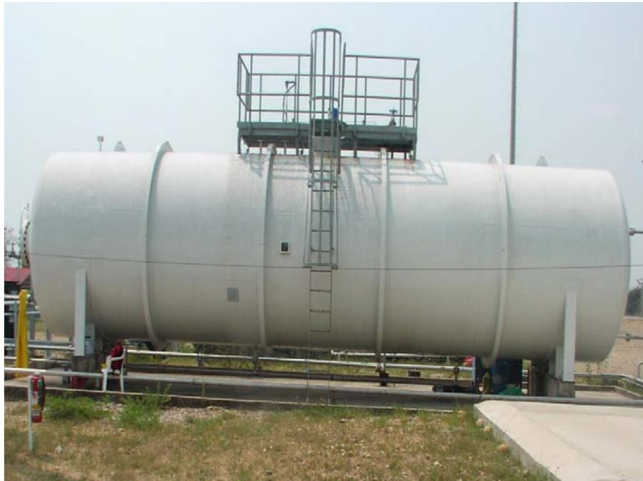
**Figura 1.2 Tanque de estabilización**
