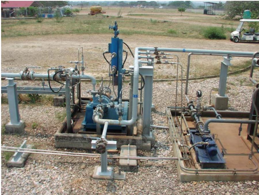
**Figura 1.7 Bomba de disposición final de lodos y bomba de disposición final de agua tratada de disposición final de lodos**
