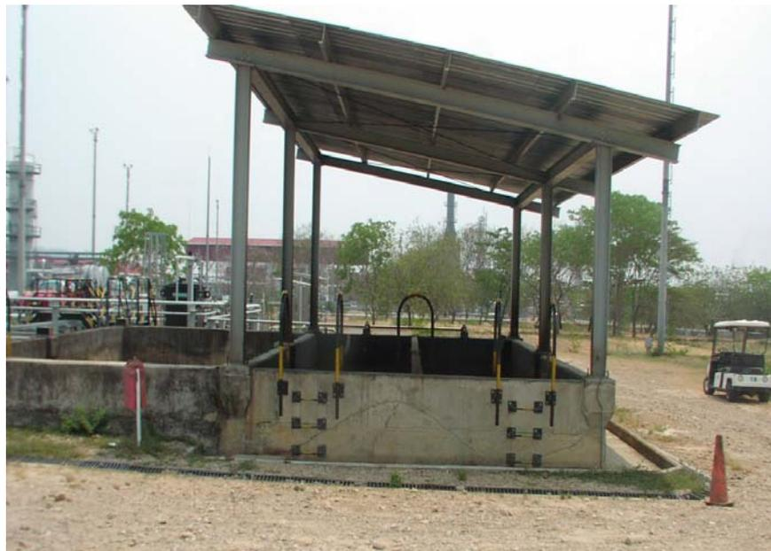
**Figura 1.10 Lecho de secado de lodos**
