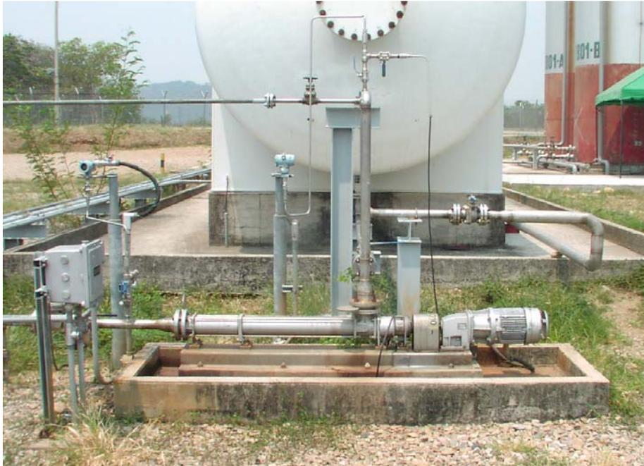
**Figura 1.3 Área de trasiego “Bomba de cavidades progresivas”**
