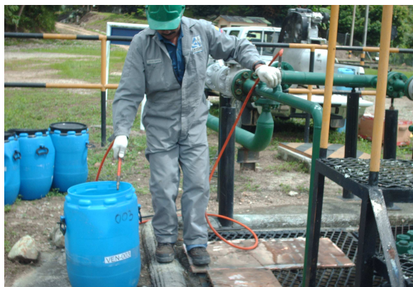
Figura 17. Completando el volumen de químico a inyectar con agua de formación
