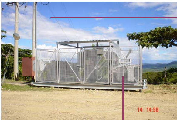
Transformador reductor (SDT)
