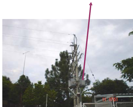
Transformador reductor (SDT)
