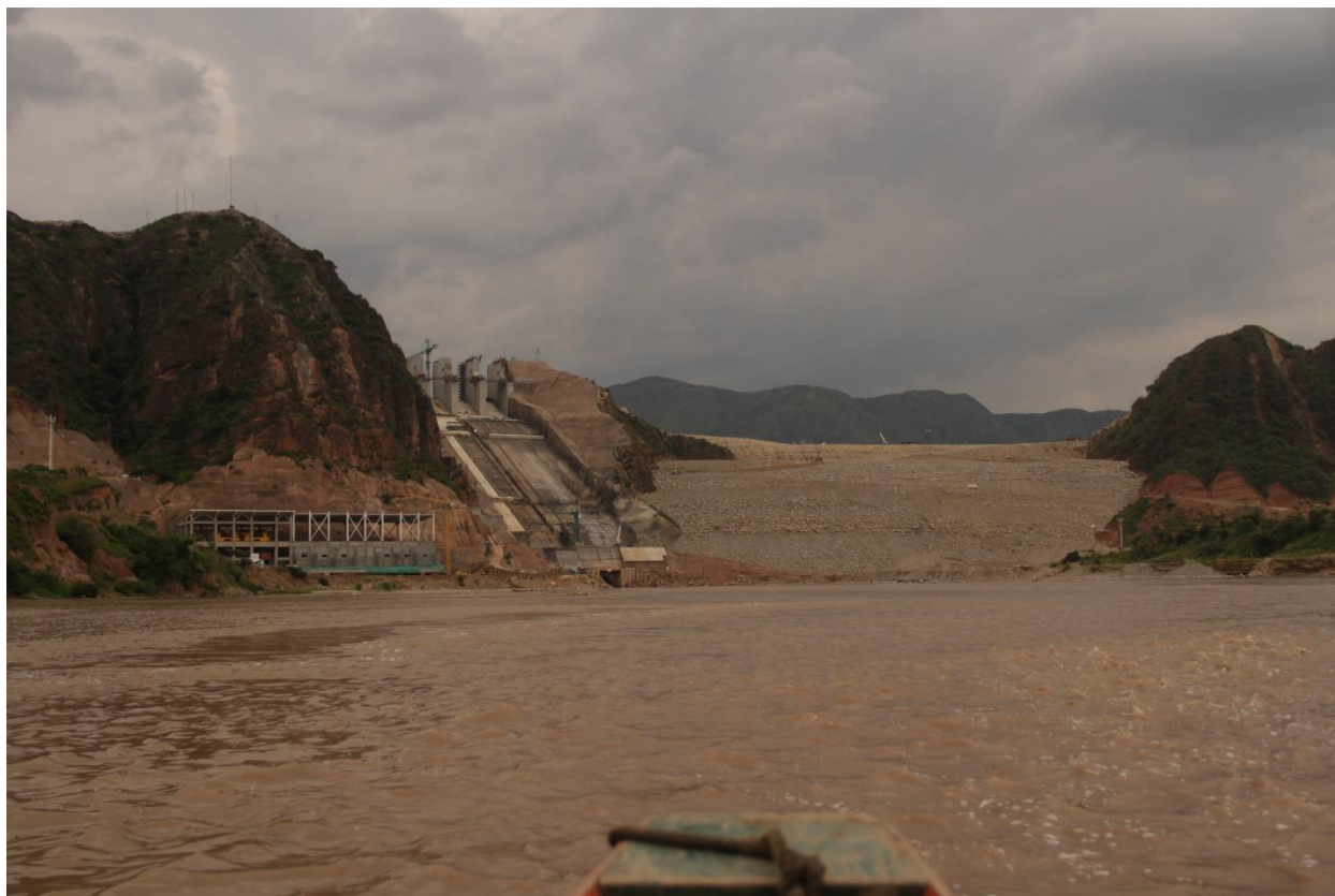
Figura 7 Compuertas Hidroeléctrica El Quimbo. Fuente: Archivo Macrorproyecto DESCA.
