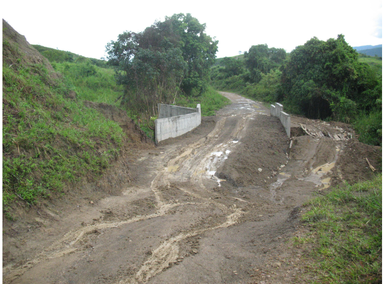
Foto 16. Reparaciones por remoción sobre la vía que conduce a Santa Ana
