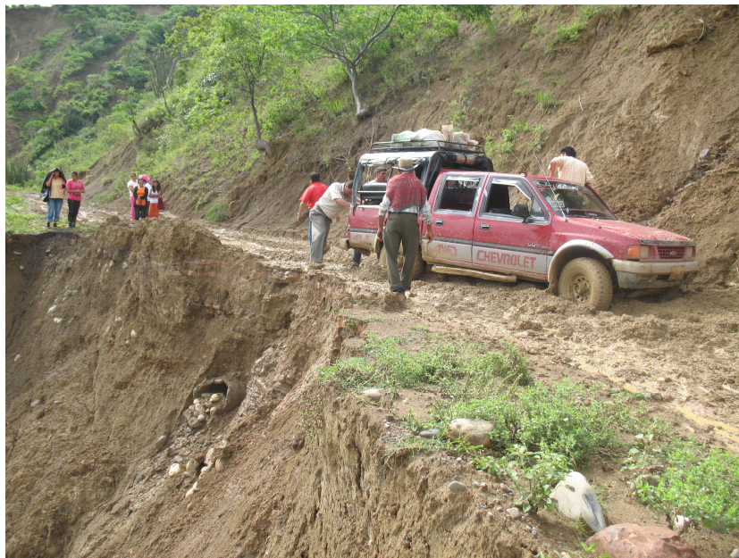
Foto 8. Deslizamiento sobre la vía Santa Ana – Colombia, sitio La Palma
