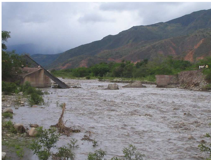
Foto 9. Creciente del río Ambicá que destruyó el pontón de acceso al casco urbano de Colombia
