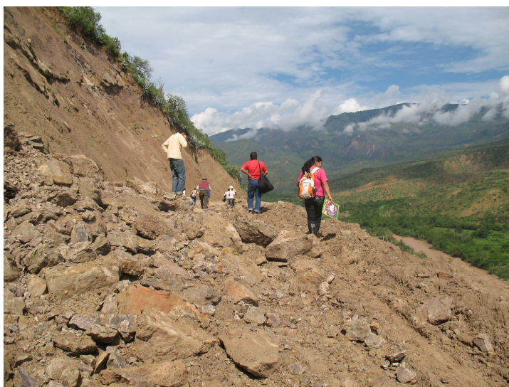
Foto 11. Desprendimiento de rocas sobre la vía Santa Ana – Colombia, sitio ‘El Volador’
