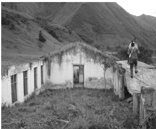
Foto N° 10. Estructuras de edificaciones que, 15 años después, reflejan la magnitud de la avalancha del 1994
