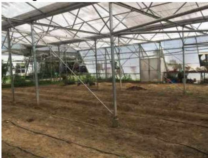
Figura 30. Sistema de Riego.
