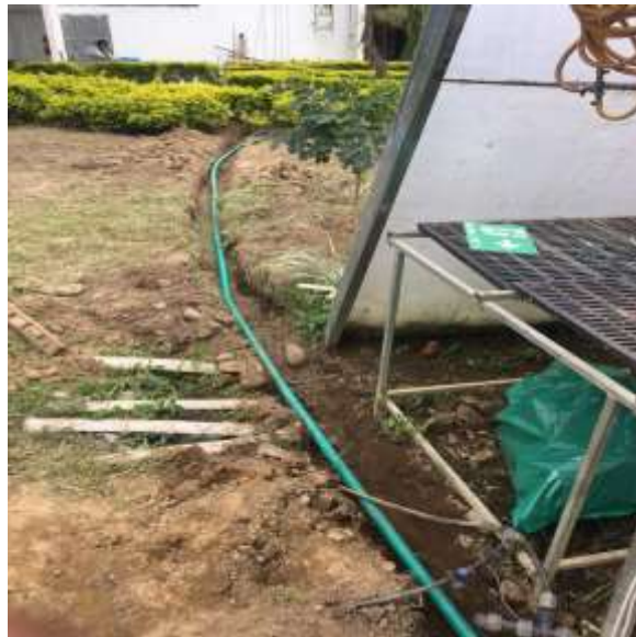
Figura 32. Comunicación Invernadero y Cuarto de Control.
